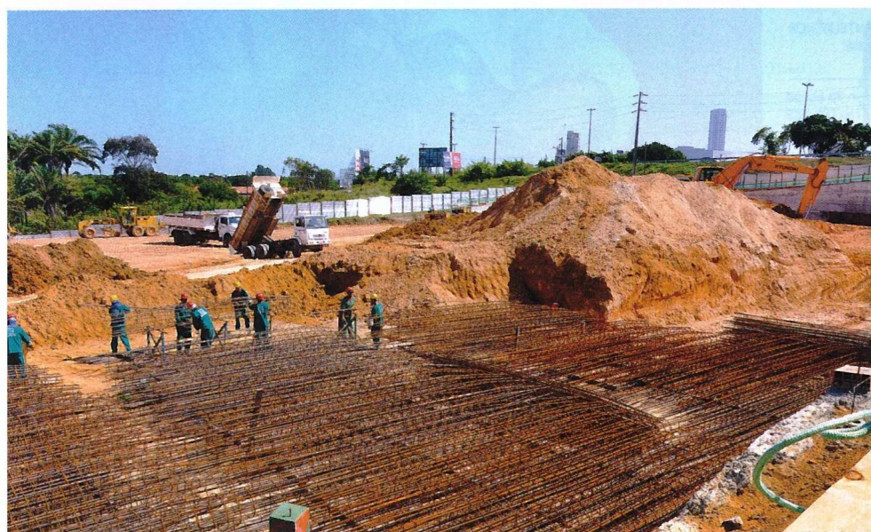
Na terraplanagem estão sendo usadas uma escavadeira hidráulica, duas motos niveladoras, dois rolos compressores, um trator escarificador e quatro caçambas
